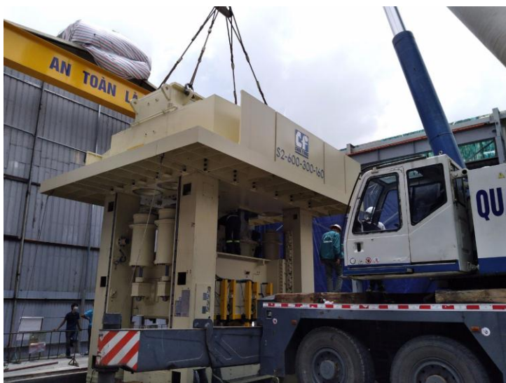
GIAO HÀNG VÀ LẮP ĐẶT MÁY DẬP GEAR ECCETRIC S2-600T (5/2021) – NẶNG 215 TẤN
