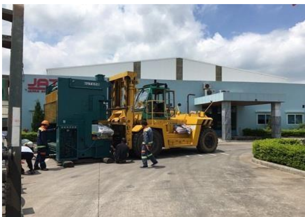
LẮP ĐẶT MÁY DẬP CẤP PHÔI TỰ ĐỘNG 150T HAI TRỤC KHUYỬU – Tháng 8/2017
