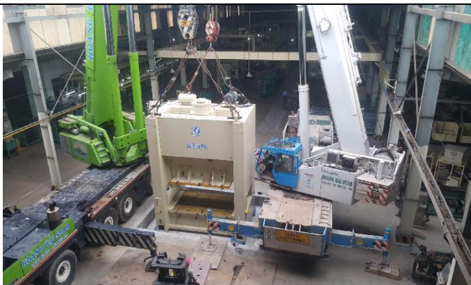
CUNG CẤP, LẮP ĐẶT MÁY DẬP 600 TẤN, 2 TRỤC KHUYỬ, LINK DRIVE 9/2019
