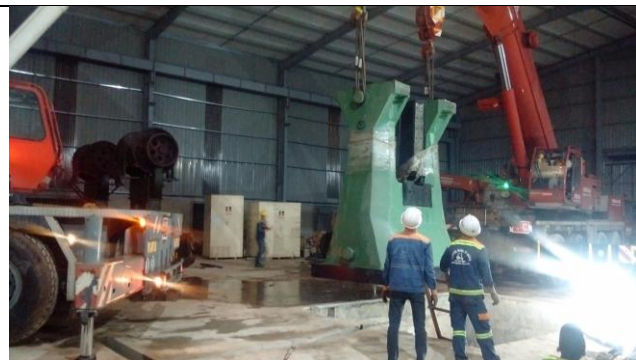
CUNG CẤP VÀ LẮP ĐẶT 02 MÁY ÉP SONG ĐỘNG NHẬT CŨ 400T & 500T – 7/2019
